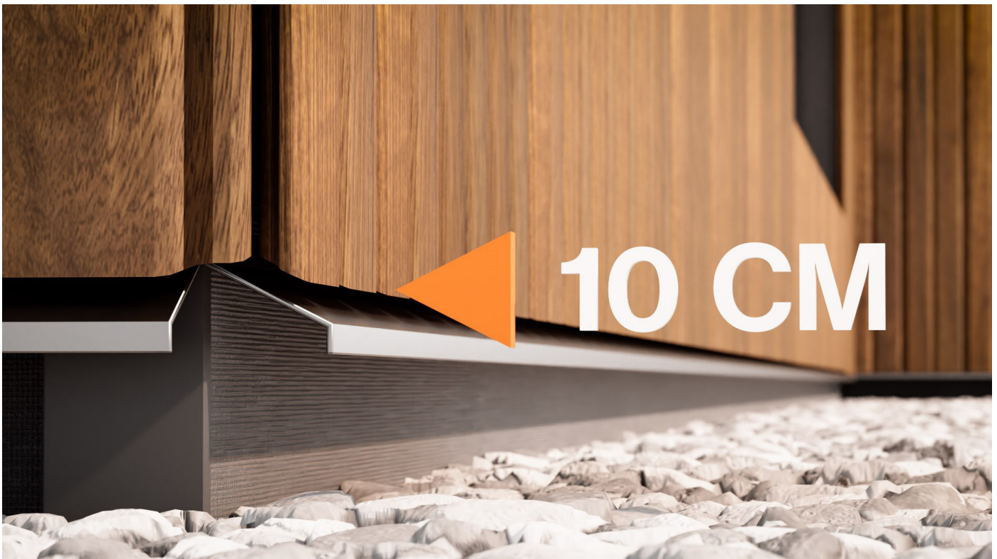
Afbeelding 10: Z-profiel met voldoende ventilatieruimte (15mm)
