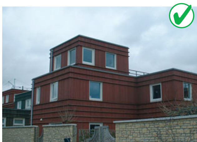
Drie lagen kleurbeits op fijnbezaagd oppervlak.
