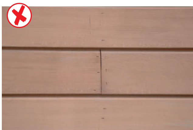
Bevestig de delen aan de uiteinden met één ringnagel met bolle kop of schroef (lenskop of bolkop).
